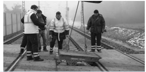
Demontaż płyt przejściowych
