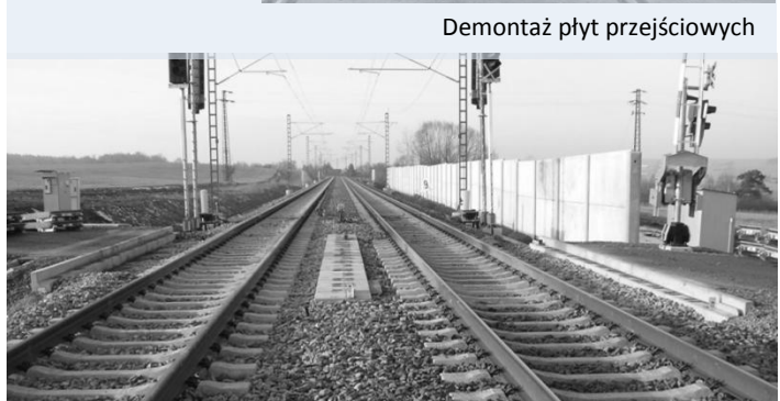
Przygotowany tor do mechanicznego ubijania podsypki torowej i szlifowania
