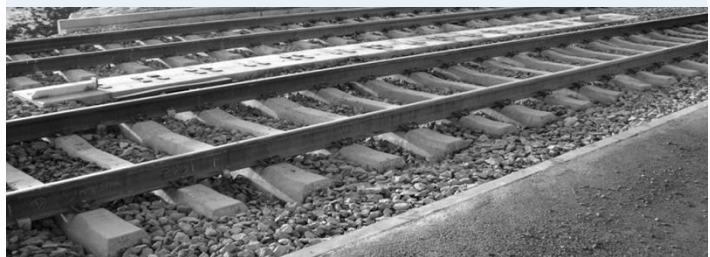
Przygotowany tor do mechanicznego ubijania podsypki torowej i szlifowania
